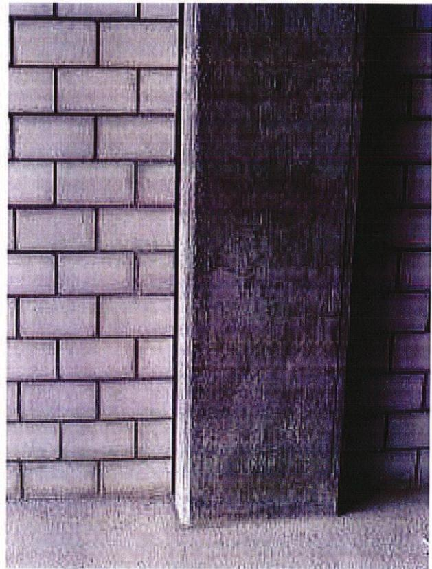
15/1 Ici, la paroi en maçonnerie et la colonne en béton armé sont séparées par un joint vertical, certainement beaucoup trop mince (Suisse, 1994).
