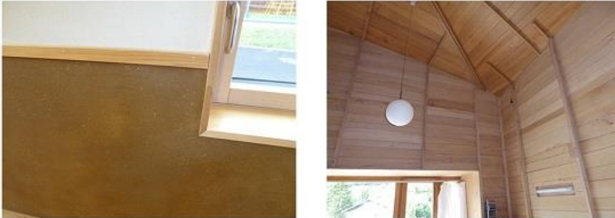
Enduit chaux/ miscanthus - mus et plafonds et murs en bois traité
