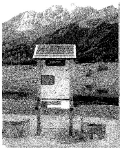
Les cellules photovoltaïques permettent l'alimentation d'une borne sonore traduisant les informations écrites et tactiles. Deux reposoirs permettent de s'asseoir ou de s'appuyer de manière temporaire.
