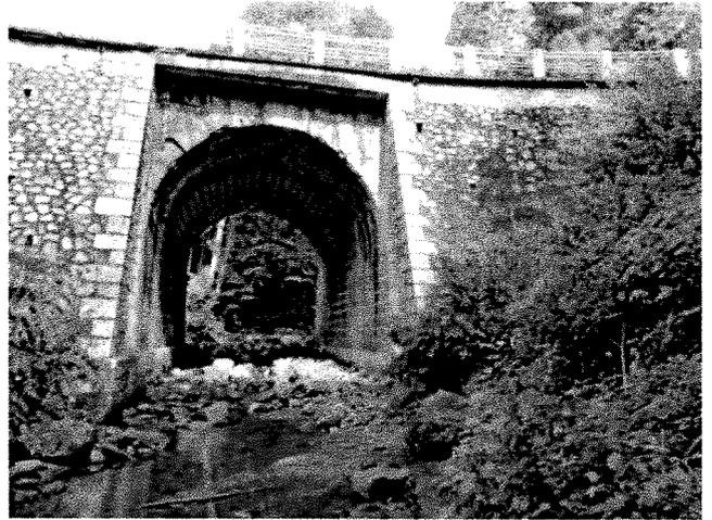
*Pont en maçonnerie affecté de divers désordres : radier en mauvais état, dégradation des bandeaux et défaillance de l'étanchéité*
