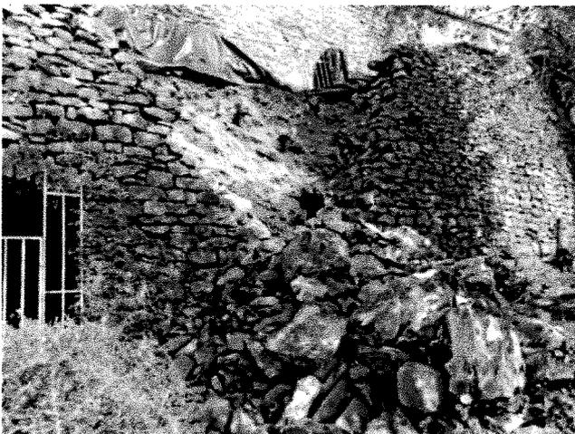
*Mur effondré à la suite d'un défaut de drainage suivi d'infiltrations et d'un cycle gel/dégel*
